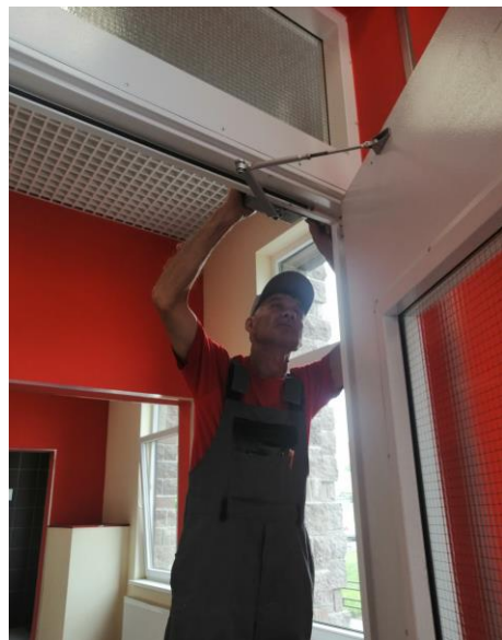
- Ремонт доводчика - Замена дверного замка - Ремонт элемента на детской площадке
