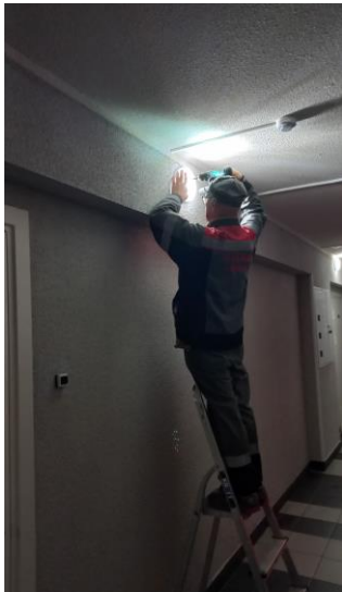
- Работа электрика - Замена светильника - ТО в ИТП
