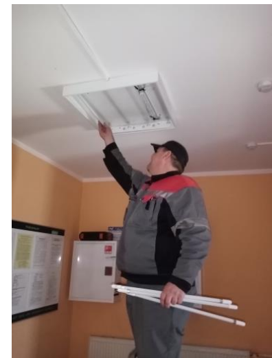
-Ремонт светильника - Ремонт электро-щита
