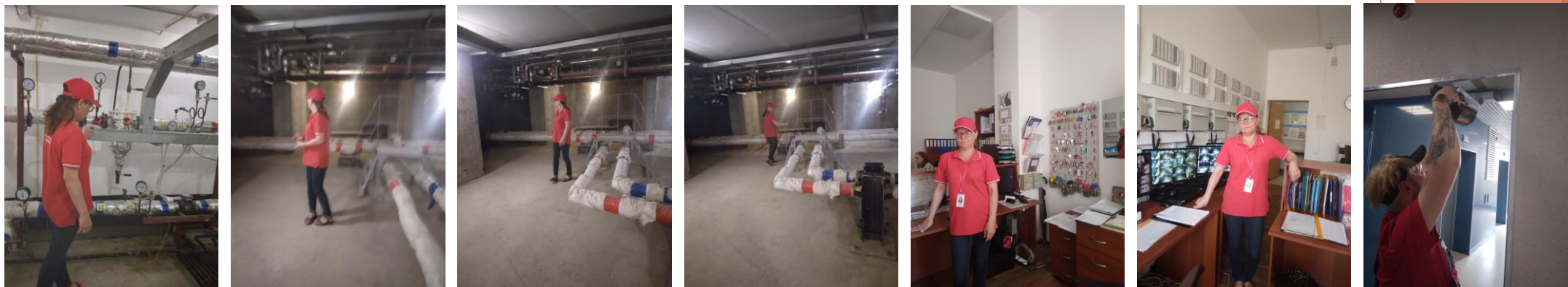
Обход тех. помещений
