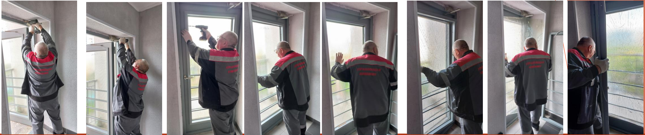
- Замена армированной двери
