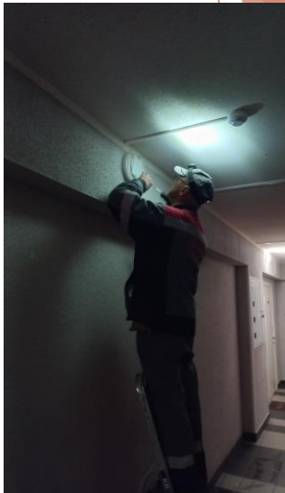
- Работа электрика - Замена светильника - ТО в ИТП
