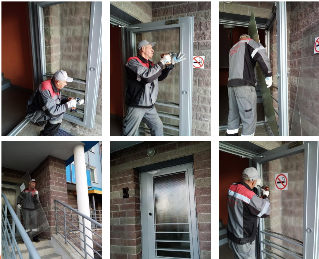
Замена армированной двери
