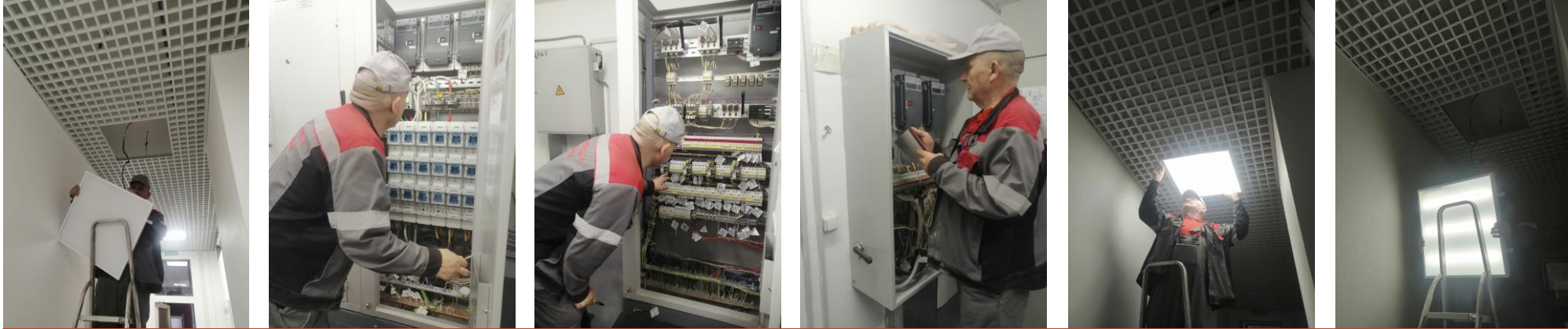
- Замена светильника - ТО в ИТП
