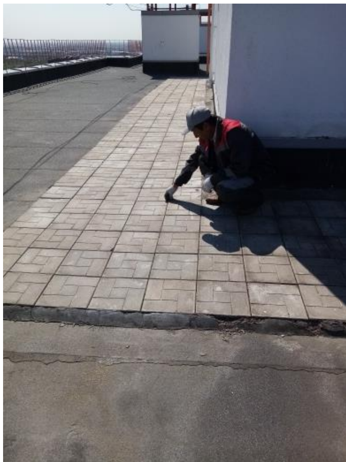
Уборка мха на крыше
