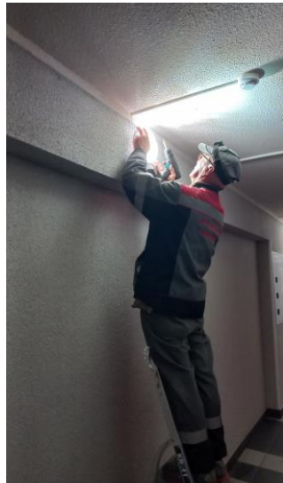
- Работа электрика - Замена светильника - ТО в ИТП
